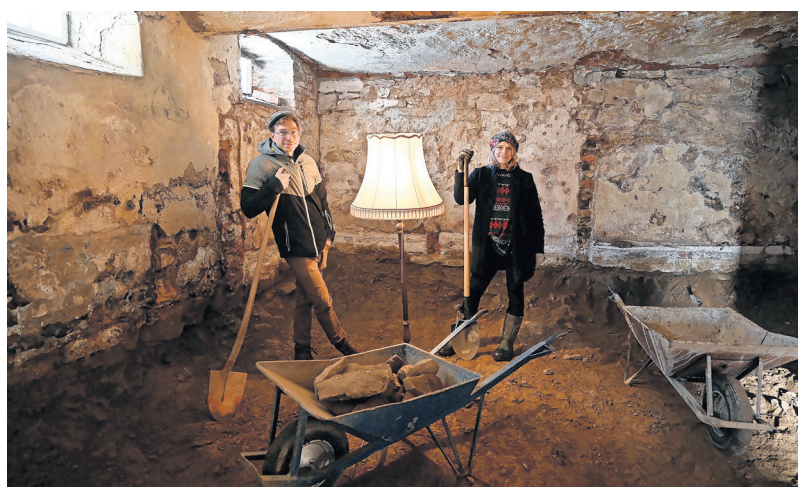
Selbst die Baulampe hat hier nostalgischen Wert: Die beiden stehen im früheren Stall, den sie derzeit ausschachten.
